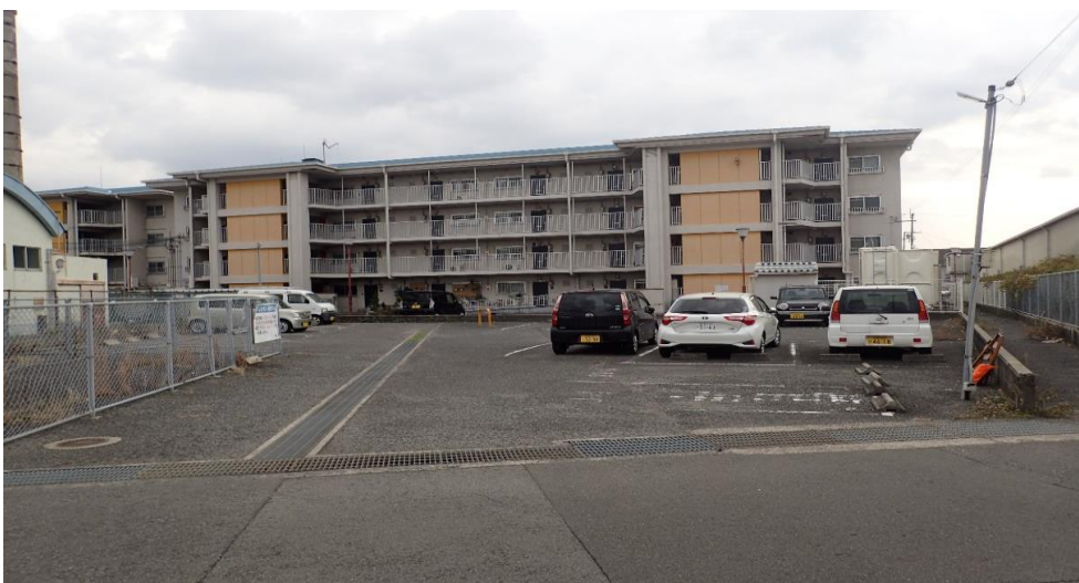
市営前畑駐車場付近
