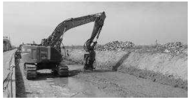
図-9 パワーブレンダー工法 施工状況
