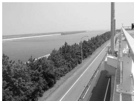
(a) 防潮壁築造前
