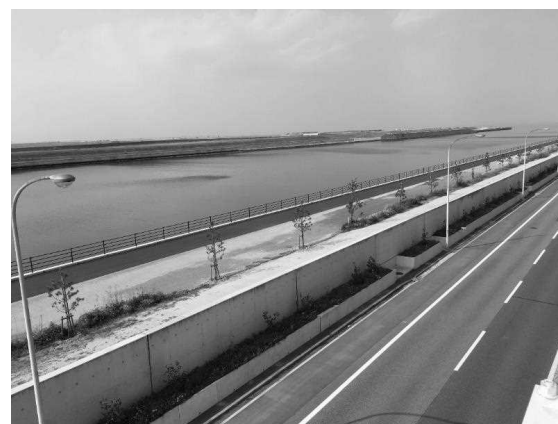
(b) 防潮壁築造後
