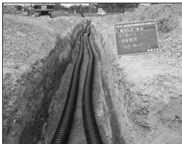
【電力配管布設】
