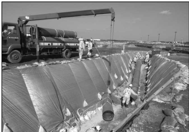
【埋設ダクト設置】
