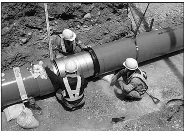
【埋設ダクト接続】
