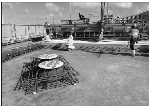
【空調ピットコンクリート打設】
