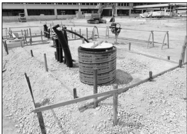
【埋設ダクトの立上り部】
