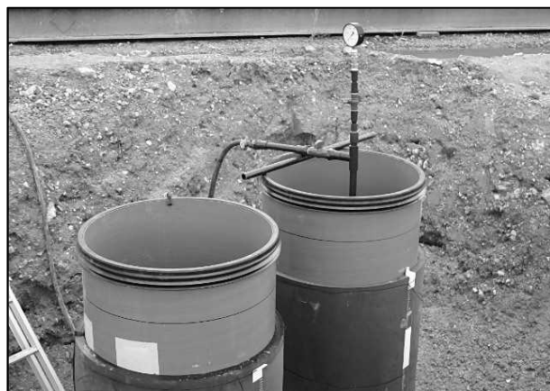
【埋設ダクト気密試験】
