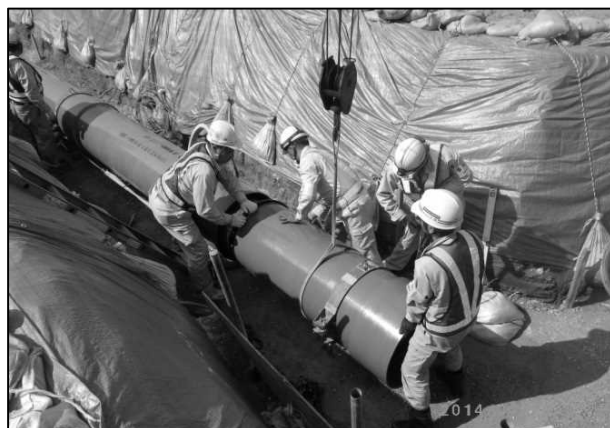
【埋設ダクト設置】
