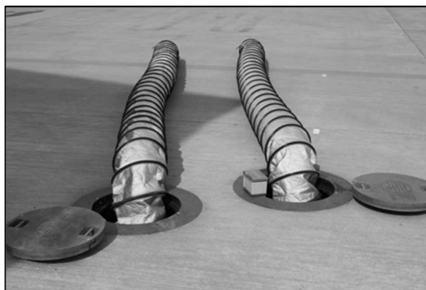
【空調ピット完成】
