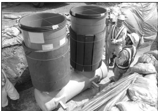
【空調ピット設置】
