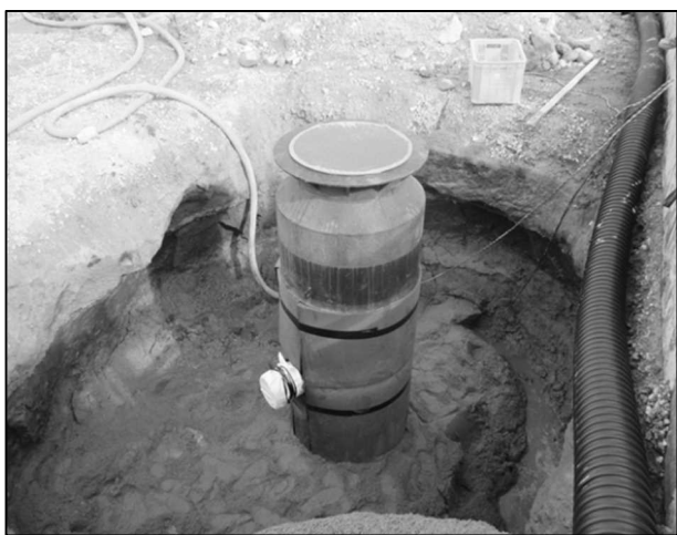
【電力ピット設置】
