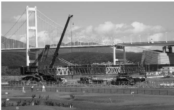
写真-2 750 t吊クローラークレーン全景
