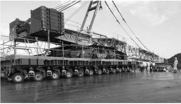
写真-5 多軸台車走行状況
