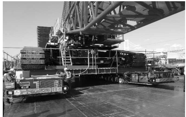
写真-4 750 t吊クローラークレーン搭載状況
