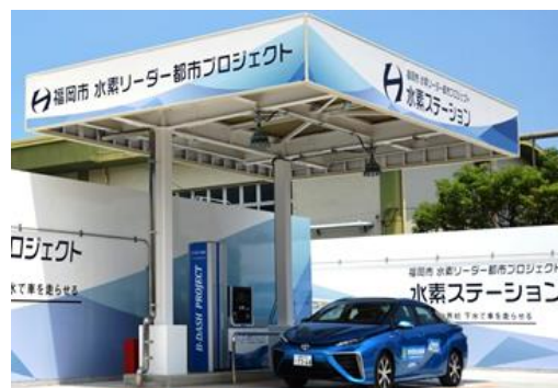
下水汚泥から製造した水素をFCVに供給する施設 (福岡市)
