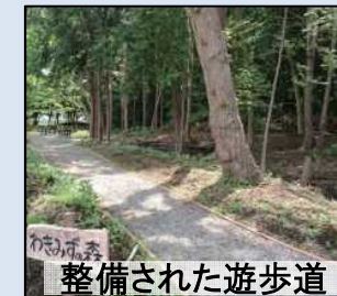
遊歩道整備の様子
