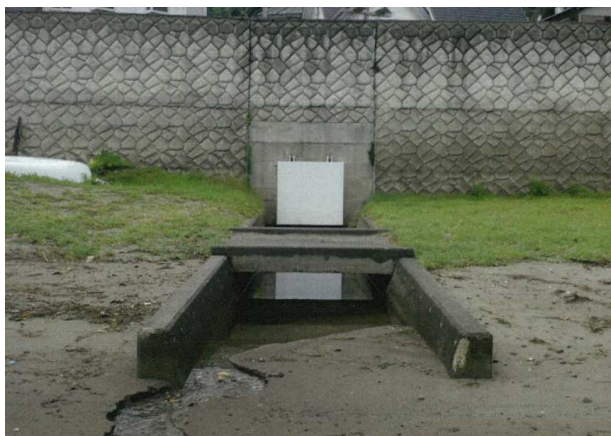
樋門(フラップゲート)
