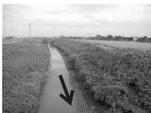
堤防の損傷はないが、越水・浸水により被害が発生したことから、河道拡幅等を実施
