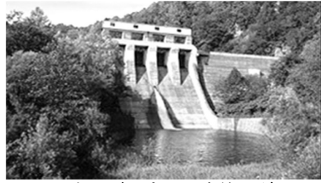
かさ上げ予定の雨竜第2ダム
