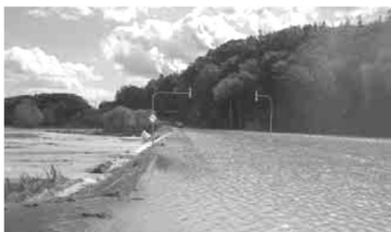
道路冠水の状況（芽室町美生川）
