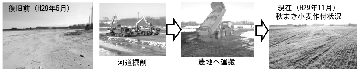
【事例】十勝川の河道掘削土を利用した農地の復旧
