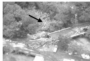
流木被害の状況（伊達市紋別川）
