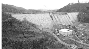
工事中のサンルダム
