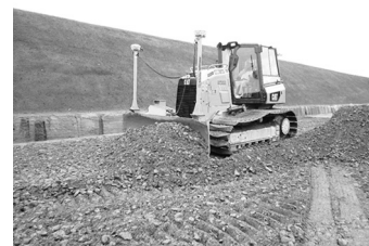
ICT建設機械による施工
