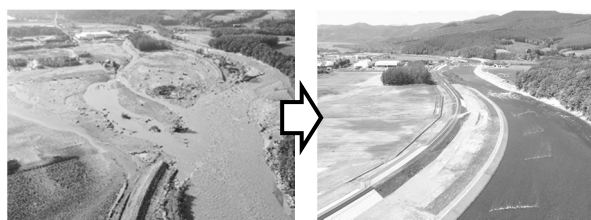
【事例】石狩川水系空知川の復旧状況
