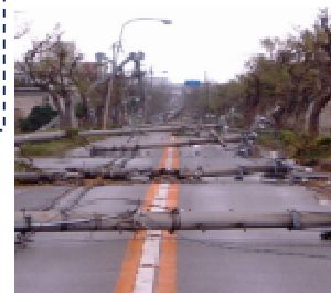
<電柱の倒壊による 道路閉塞>
