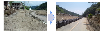
災害時の道路啓開
