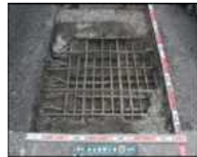
<阪神高速 12号守口線 南森町付近>
