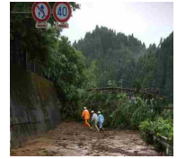
災害により通行できなくなった道路
