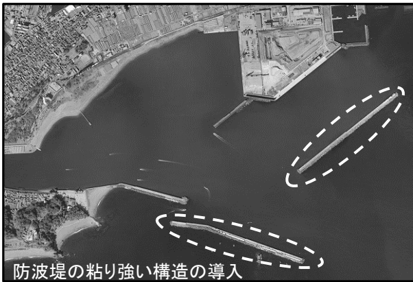
防波堤の粘り強い構造の導入 粘り強い構造の防波堤の整備事例：高知港
