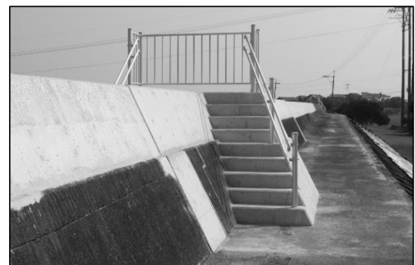
陸閘の廃止：大分県中津港海岸
