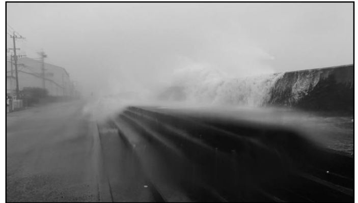
既存護岸の越波状況：大分港海岸
