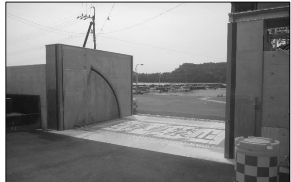
陸閘の自動化：徳島県浅川港海岸
