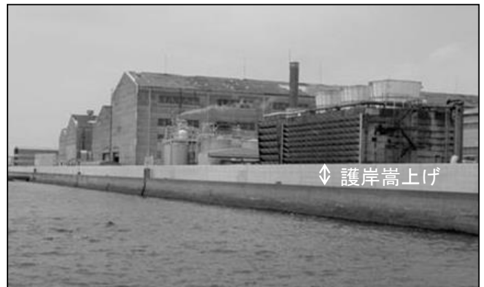
背後の産業を守る護岸の嵩上げ状況：広島港海岸
