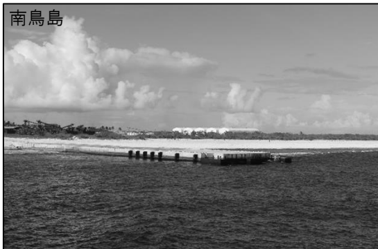
特定離島港湾施設の整備状況
