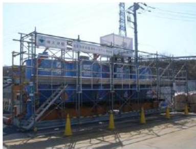
処理設備の外観
