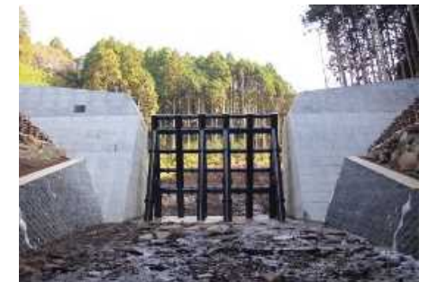
流木捕捉効果の高い 透過型砂防堰堤イメージ
