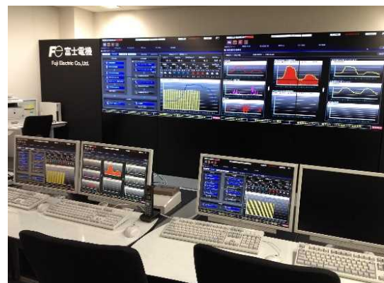
CEMS により地区のエネルギーを管理
