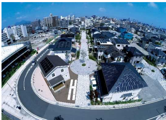
住宅に太陽光発電設備等を設置
