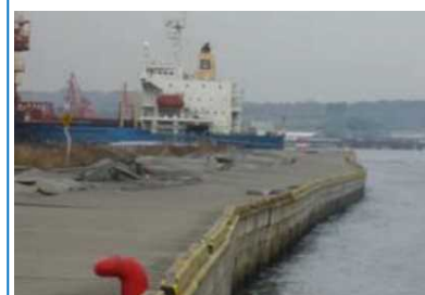
被災事例(岸壁のはらみ出し)
