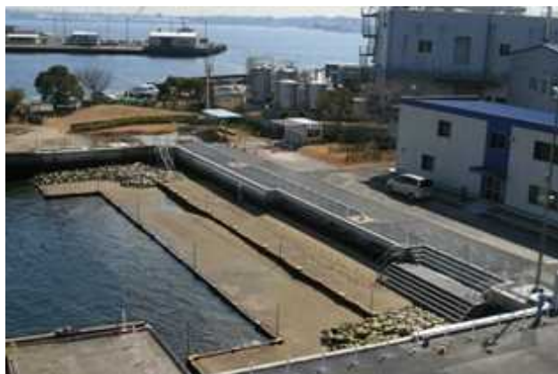
老朽化した護岸に生物共生効果を併せ持つ「護岸」と「磯場」を設置
