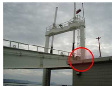
可動橋被災箇所
