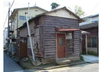
【分譲当初のままの平屋建て住宅（空き家）】
