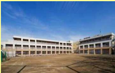
学校を改修して整備した事例
