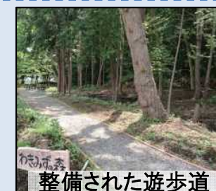
遊歩道整備の様子
