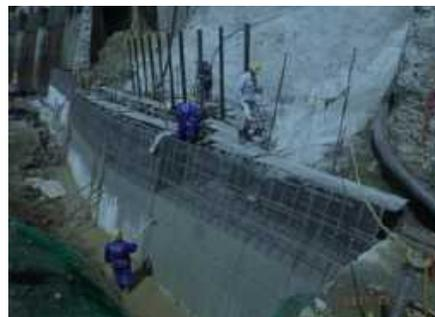
擁壁工 外壁の埋設型枠
