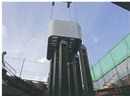
橋梁下部工 橋脚部の埋設型枠
