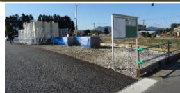
元農地は盛土造成。車路は舗装、他は砂利敷き
