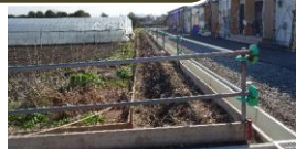
隣接農地に生活排水が流れこまないように側溝を設ける
