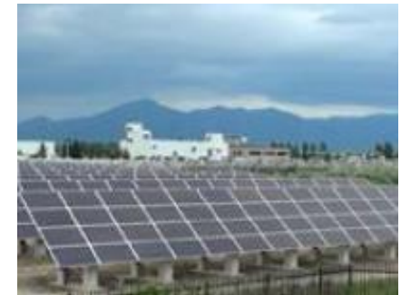
山形県 山形浄化センター
