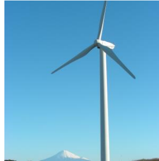
静岡県 中島浄化センター
