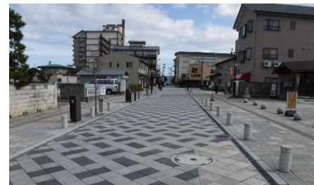
無電柱化、石張舗装、歩道整備
