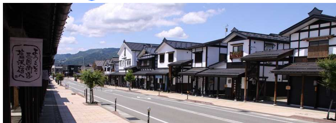
建造物の所有者がそれぞれの負担により雁木を整備
