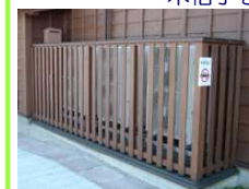
室外機の目隠し
