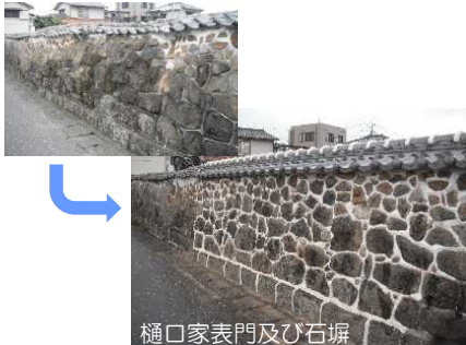
樋口家表門及び石塀
