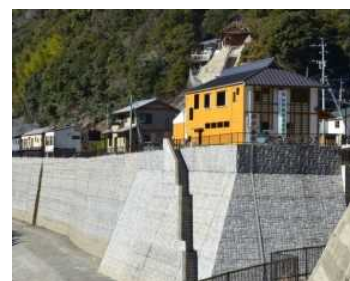
景観に配慮された擬岩擁壁
