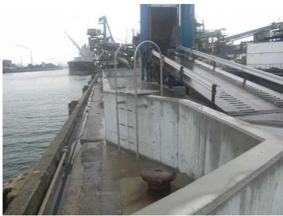
写真 2.2.7 岸壁水際部分の嵩上げ
