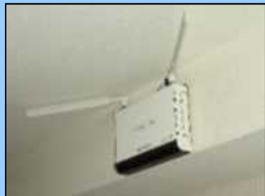
無料公衆無線LAN環境の整備
