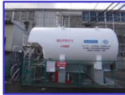
LNG燃料タンク
