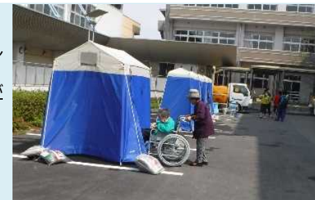
写真上：熊本市で活躍したマンホールトイレ
