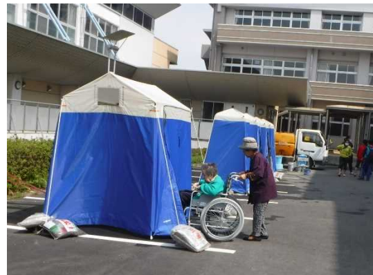
写真 1-1 熊本市で使用したマンホールトイレ (提供:熊本市)
