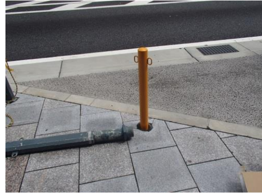
写真9 脱着式のボラード・横断防止柵
