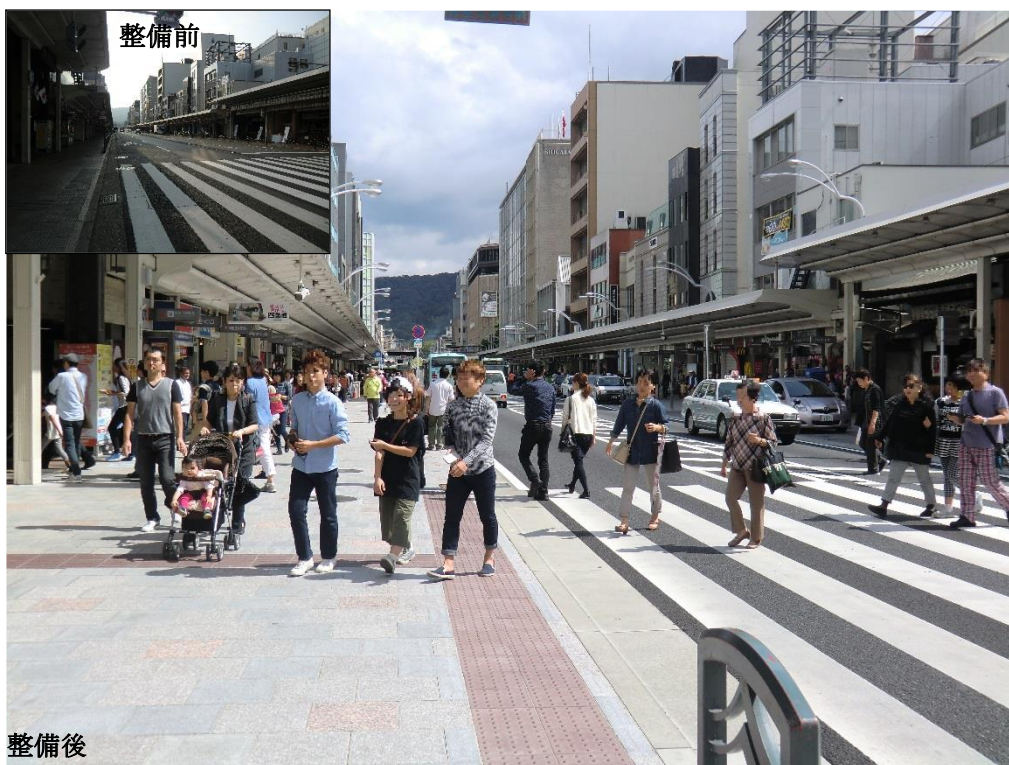
写真2 幅員が約2倍になった歩道
