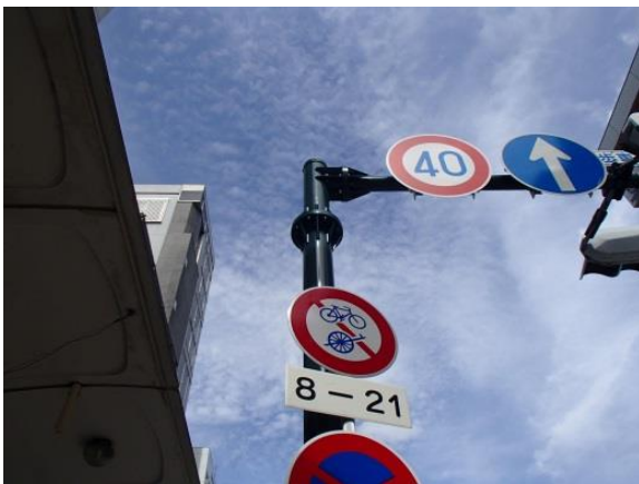
写真10 信号柱の回転機構
