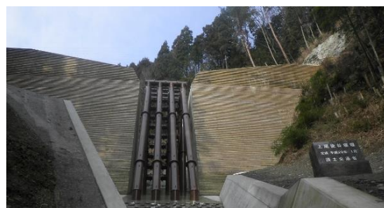
(河川) 吉野川水系祖谷川 (徳島県三好市) 『砂防堰堤 (残存型枠)』
