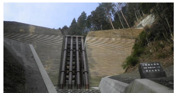
吉野川水系祖谷川（徳島県三好市） 『砂防堰堤（残存型枠）』
