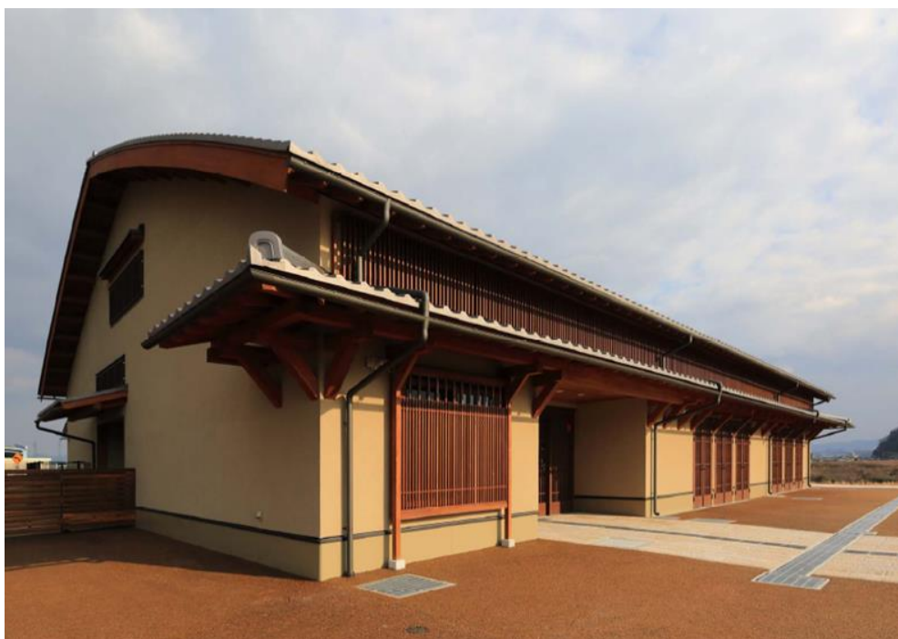
淀川河川公園背割堤地区（京都府八幡市）：管理棟
