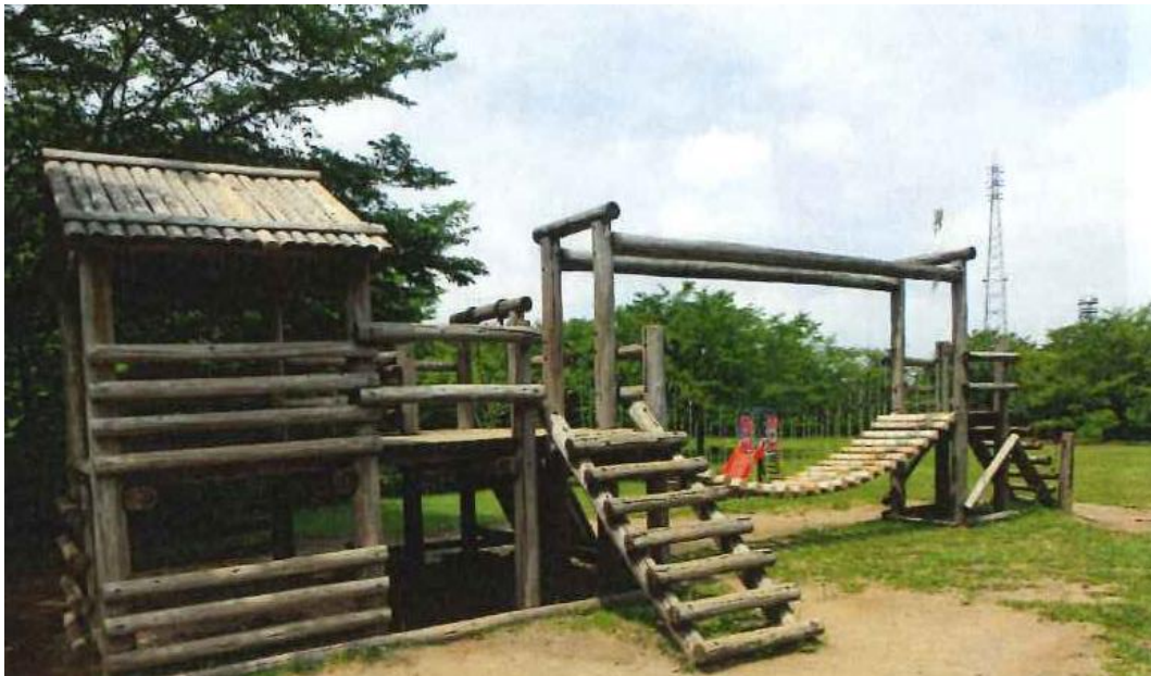
四街道総合公園（千葉県四街道市）：遊戯施設
