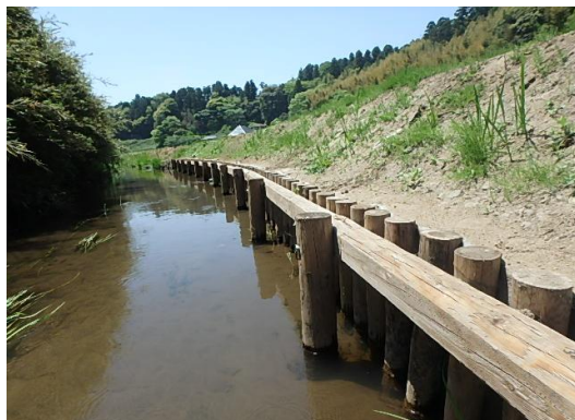
栗山川水系栗山川（千葉県香取市） 『法留工（杭柵）』
