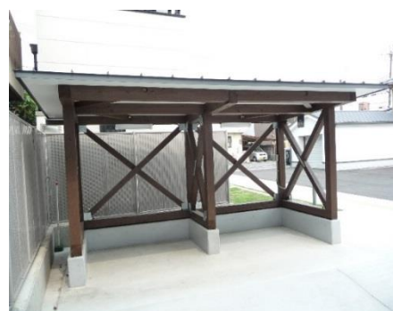
奈良地方気象台(奈良県奈良市)：自転車置場 (木造)
