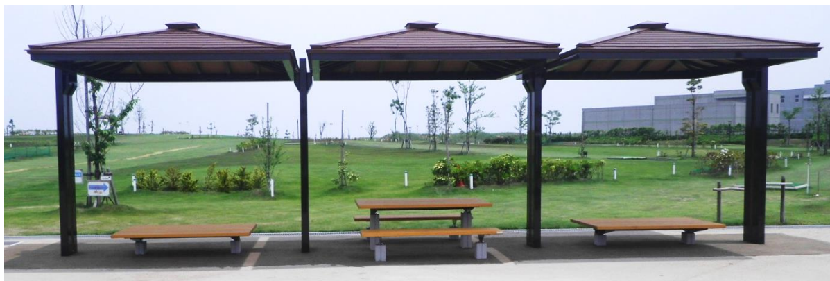
伏木富山港（富山県射水市）：四阿（野外卓、ベンチ）
