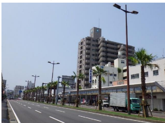
樹木の支柱 国道10号 (宮崎県宮崎市)
