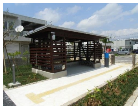
那覇地家裁石垣支部庁舎（沖縄県石垣市）： 自転車置場（木造）
