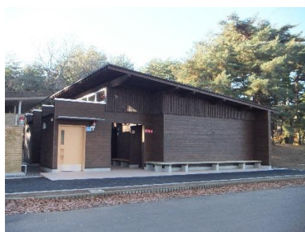
(公園) 国営常陸海浜公園 (茨城県ひたちなか市): トイレ棟
