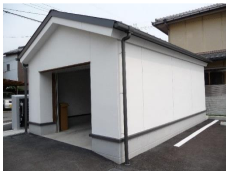
奈良地方気象台(奈良県奈良市)：車庫（木造）
