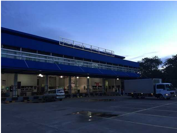
【ヤンゴン航空貨物ターミナルの様子】
