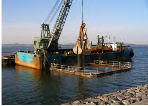
図 3.13.11 覆砂工事施工状況
