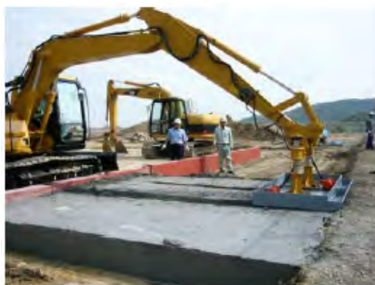
図 3.13.2 施工（締め固め）状況
