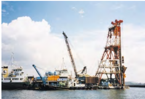
図 3.13.10 SCP 施工状況
