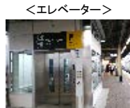
<エレベーター>
