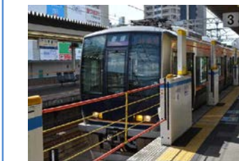
昇降ロープ式ホーム柵 (支柱伸縮型)
