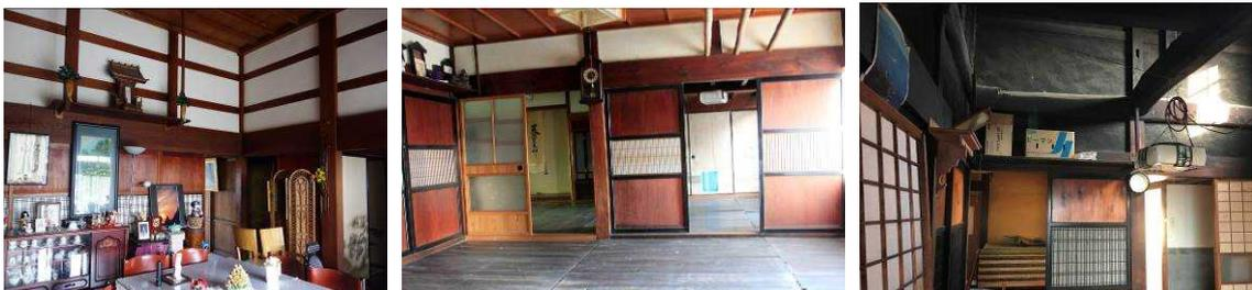
写真2 地産材による柱・梁・貫
