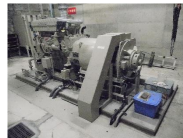
ハ403 発電機及び原動機の状態
