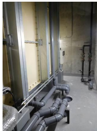
キ201 給水タンク等の設置の状況
