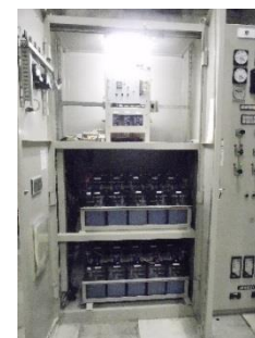
ヒ503 蓄電池の設置の状況
