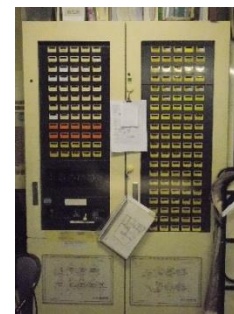
ハ110 中央管理室における制御及び作動状態の監視の状況
