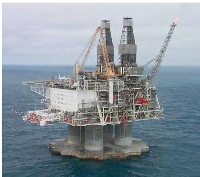
図 4.3.2-1 重力式プラットフォーム（コンクリート製）
