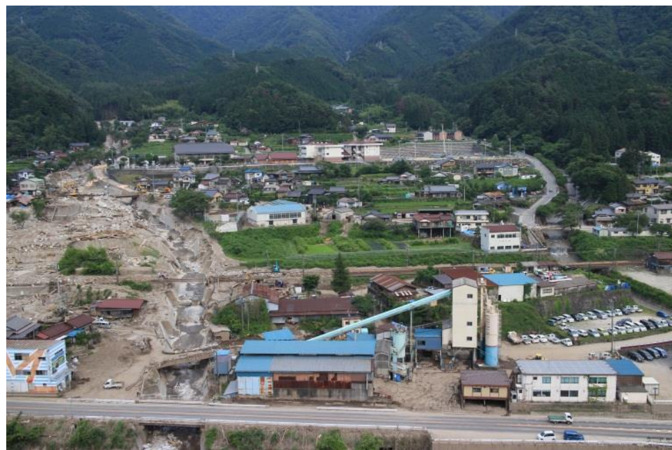
長野県南木曾災害 斜め撮影写真
