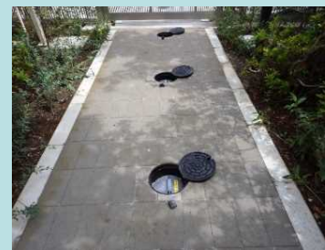
マンホールトイレ
