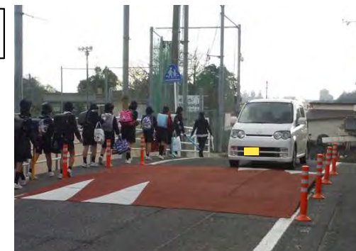
可搬型ハンプの試行的設置 (広島県福山市大津野小学校地区)
