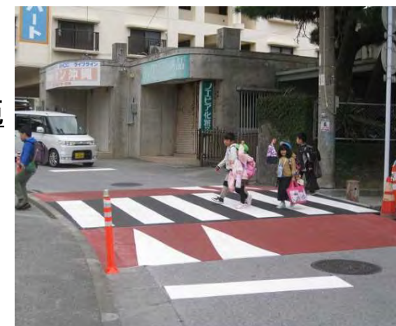
横断歩道部を盛り上げたハンプの設置 (沖縄県浦添市港川地区)
