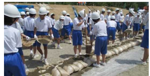
中学生による水防工法体験
