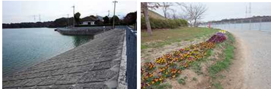
改修した副堤防（平成30年3月撮影）
