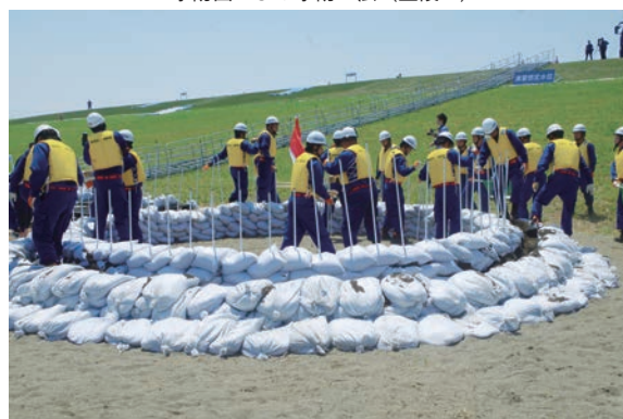
水防団による水防工法（釜段工）
