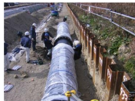
管路の耐震化(徳島市)
