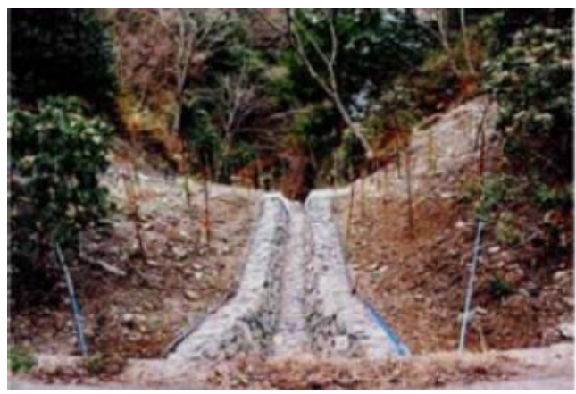
整備後の溪流工
