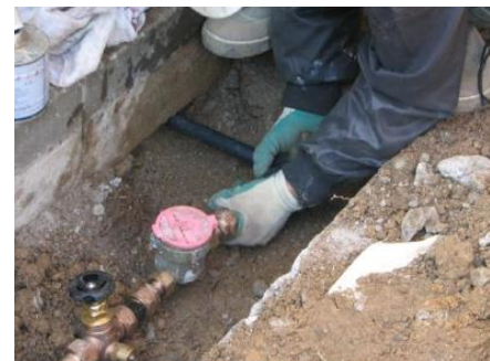
鉛管取替作業(高松市)
