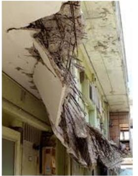
築35年マンションの2階廊下部分が崩落した事例
