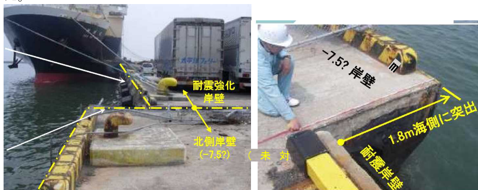
図 3-3 仙台塩釜港仙台港区高松埠頭岸壁
