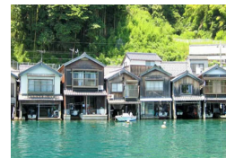
舟屋をカフェ・宿に改装して運営（伊根 油屋の舟屋「雅」）
