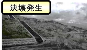
堤防より低い位置に架かっているJR京浜東北線付近の堤防から洪水が氾濫し、堤防が決壊。
