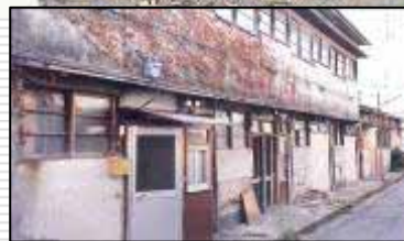
老朽木造アパート
