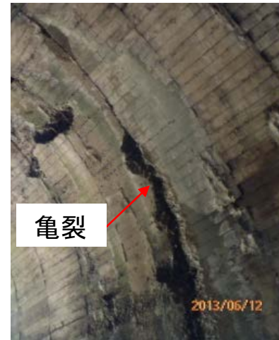
トンネル壁面上部1
