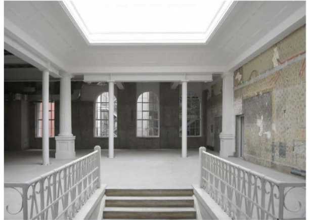
写真 13 竣工 2階吹抜部
