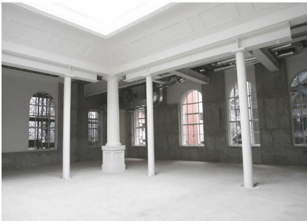
写真 14 竣工 2階吹抜廻り鉄骨補強
