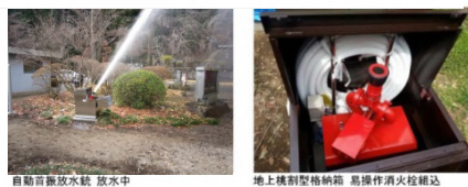
自動首振放水銃 放水中 地上横型格納箱 易操作消火栓組込
