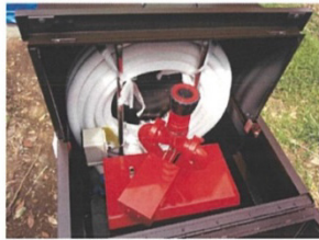
地上桃割型格納箱 易操作消火栓組込（イメージ）
