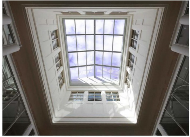
写真 11 竣工 2階吹抜部
