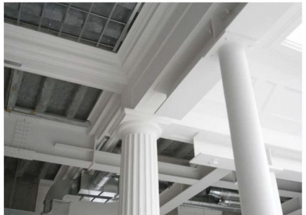
写真 15 竣工 2階吹抜部既存柱廻り
