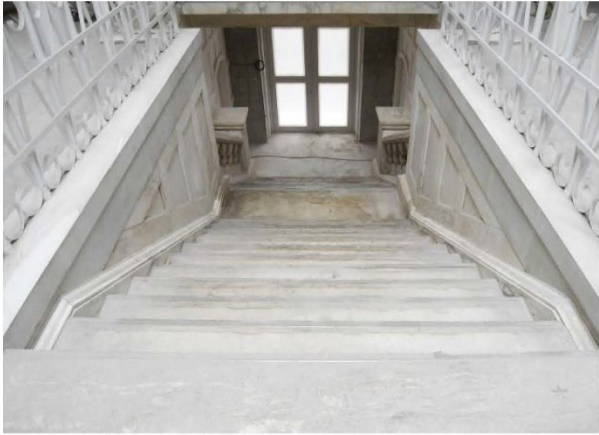
写真 12 竣工 中央階段
