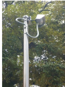
炎検知器（ポール上布設）（イメージ）
